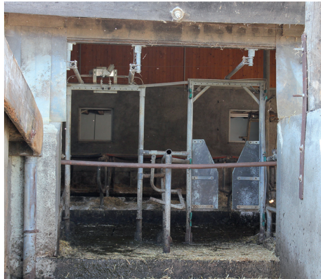
Das Selektionstor beim Übergang vom Stall in den Laufhof wird nicht mehr genutzt. Es läuft aber trotzdem noch im Standby-Modus.
