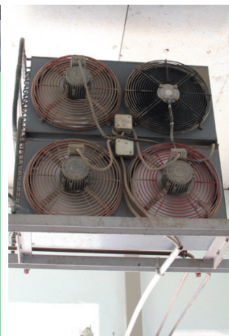
Das Kühlttaggregat braucht in Gebäuden mehr Strom.
